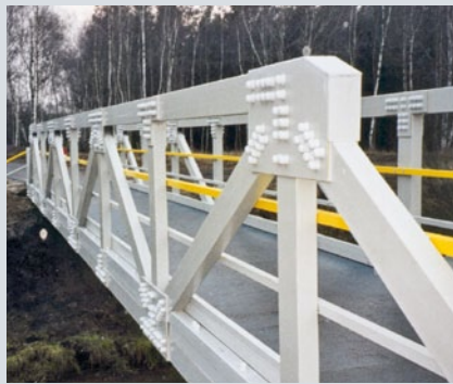
Bild 3: Fußgängerbrücke in Senftenberg
