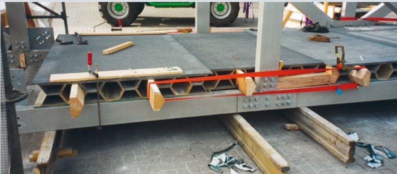
Bild 5: Fixieren der verklebten Segmente mittels Streben und Spanngurten
