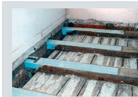
Bild 8: Restaurierung von Deckenträgern unter Einsatz von GFRK-Profilen (Bild: Fiberline Composites AS)
