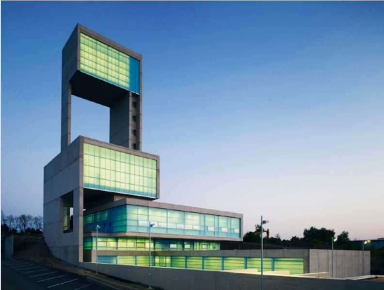
Bild 9: Transluzente Composite-Fassadenelemente am Betriebszentrum der Gemeinde Leudelange (Bild: Butzbach GmbH)
