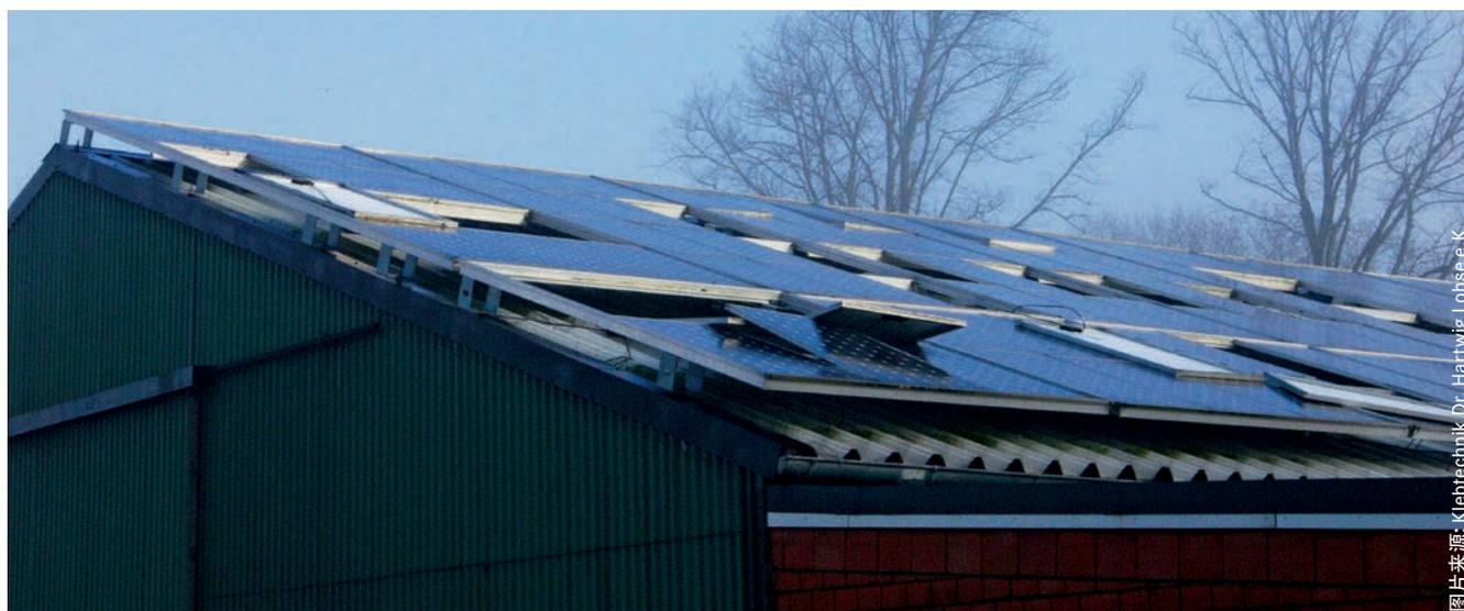
图1：曝露于大风下一排一排的粘接失效，由于严重的粘接失误，太阳能电池板和铝基板之间粘接失效。
